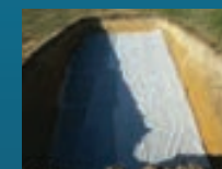
POSE DU GEOTEXTILE
