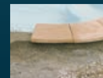
POSE DES MARGELLES
